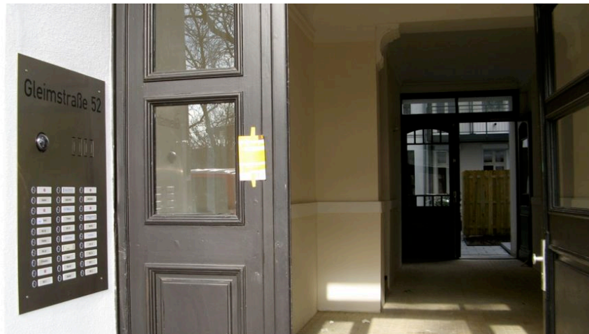
Das Haus in der Gleimstraße 52 nach der Sanierung. (Foto: Juliane Wiedemeier)
